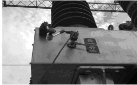
35KV SF6 开关传感器安装
